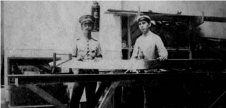
Imagem 12. Capitão Villela Júnior trabalhando em sua oficina na construção de uma hélice (circa 1920).
