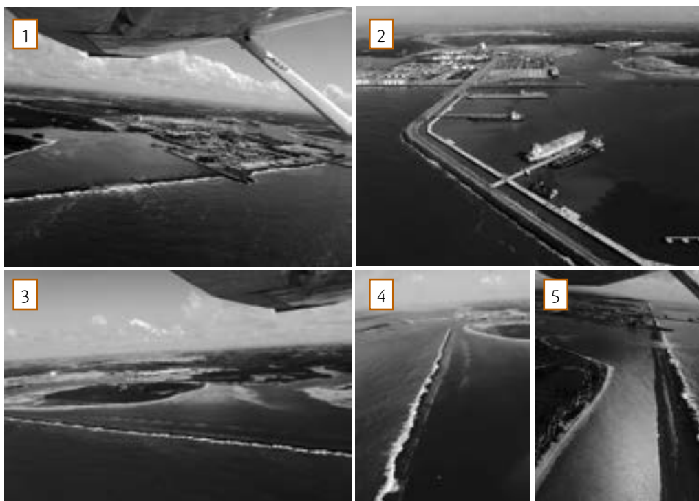
Foto 1. Vista aérea da desembocadura artificial dos rios Ipojuca e Merepe na Baía do Ipojuca
