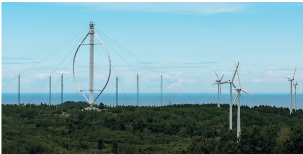
Foto 1. Turbina de eixo vertical (esquerda) e turbina de eixo horizontal (direita)
