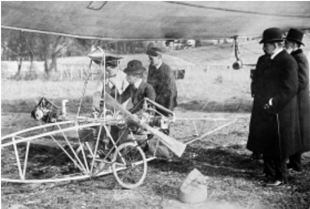
Santos Dumont, com um dos seus mecânicos, testa o motor de seu invento de número 16: um híbrido, misto de balão com avião, mais pesado que o ar, que não foi bem sucedido (1907).
