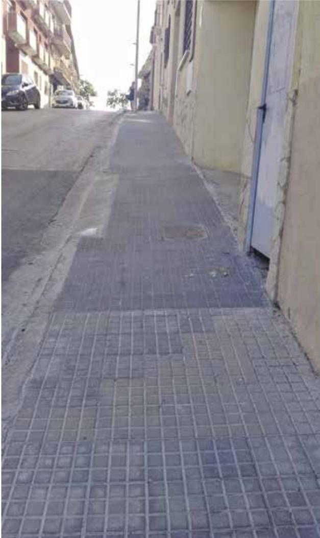
**Foto 21.** Silent de 9 pastillas colocado en calle en pendiente junto a pavimento original
